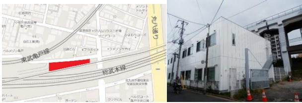
図 5 線路脇タイプ 施設場所・外観 表 3 線路脇タイプ 構造・仕上げ
